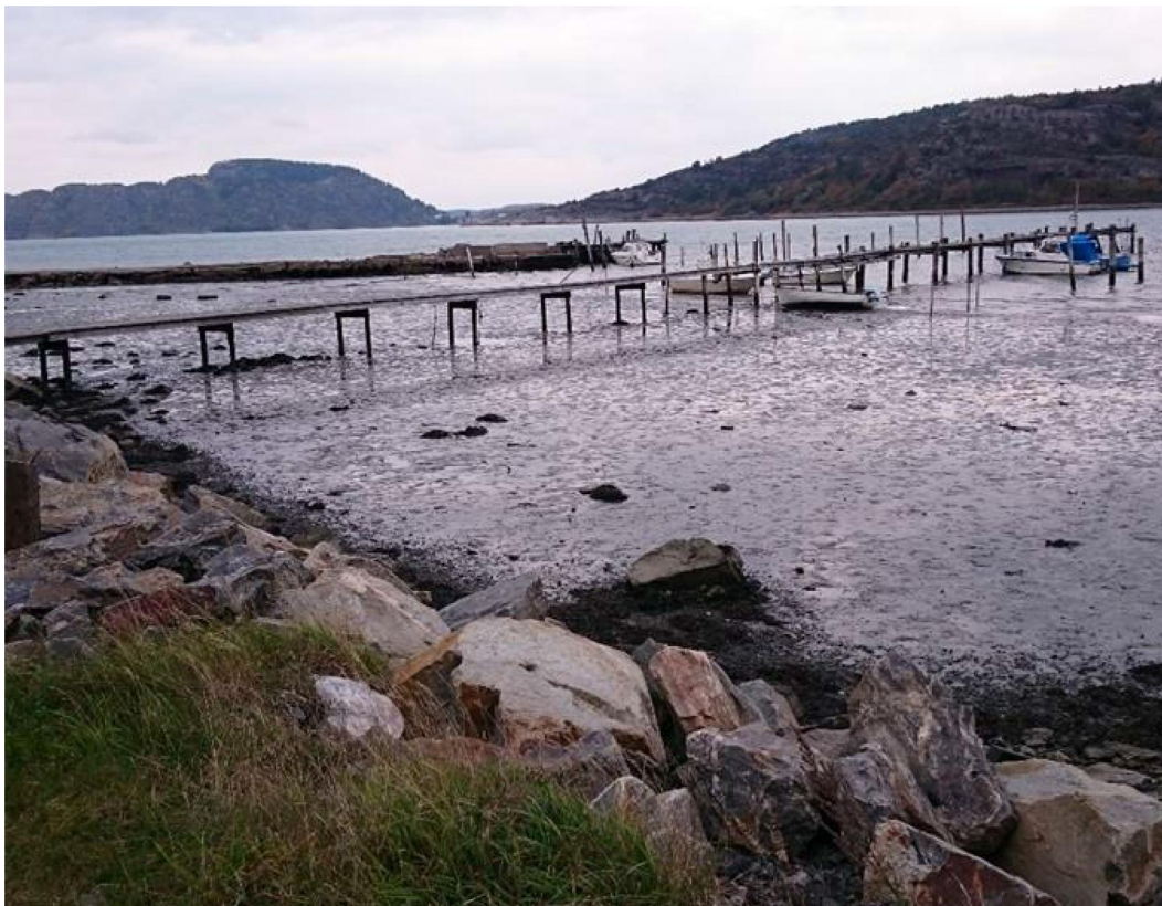
Figur 6, Vy åt nordväst, brygga nr 2 samt vågbrytare i förgrunden (2014-10-07).
