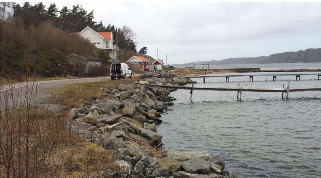
Figur 4: Sprängstensfyllning längs strandkant. Fotoriktning mot väster.
